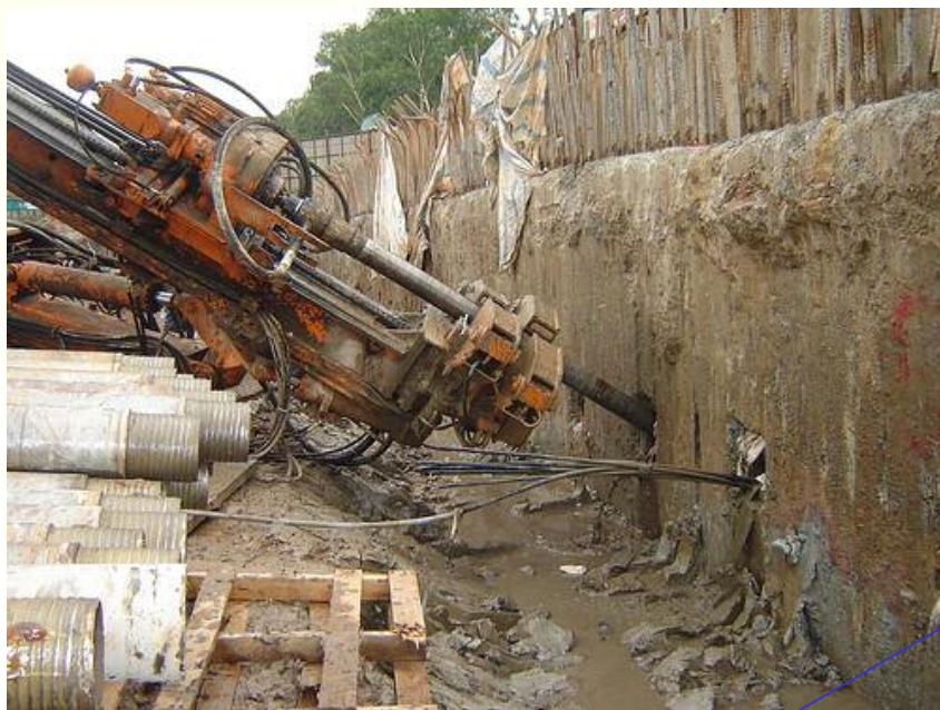
Khoan và neo cáp cho tường trong đất, Samwoo Geotech Korea, Keangnam Phạm Hùng, Hà Nội, 6/2008
