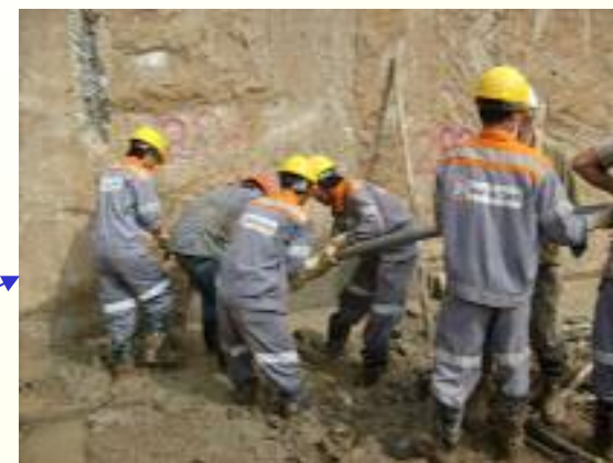
Luồn bó neo cáp vào hố khoan, Bachy Soletanche, EVN 11 Cửa Bắc, Hà Nội tháng 5/2008
